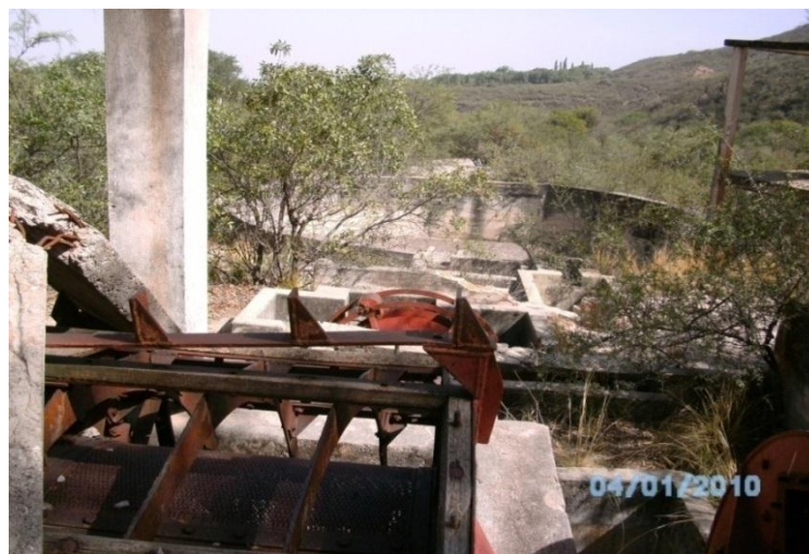
Figura 6: La mina de caolín abandonada, tuvo su gran auge a comienzos del siglo XX.
