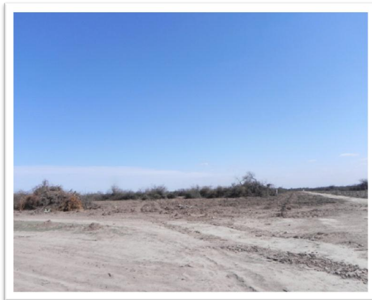
Figura 6: Avance del desmonte en el paraje Barrancas.
