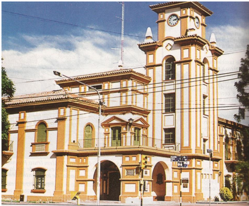
Figura 7. Edificio Municipal de San Martín, centro regional del este mendocino
